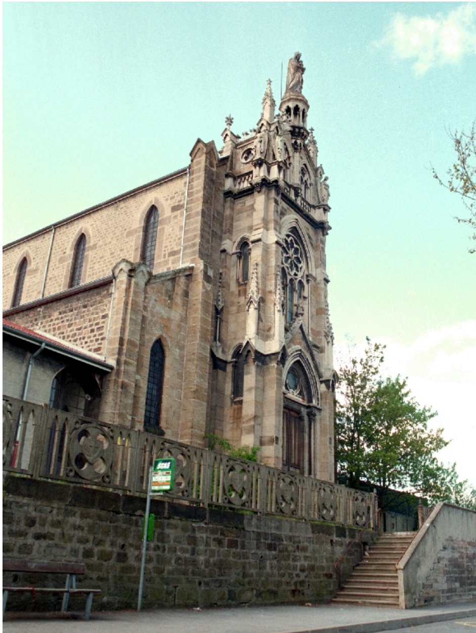
Façade principale, sur la place, au nord
