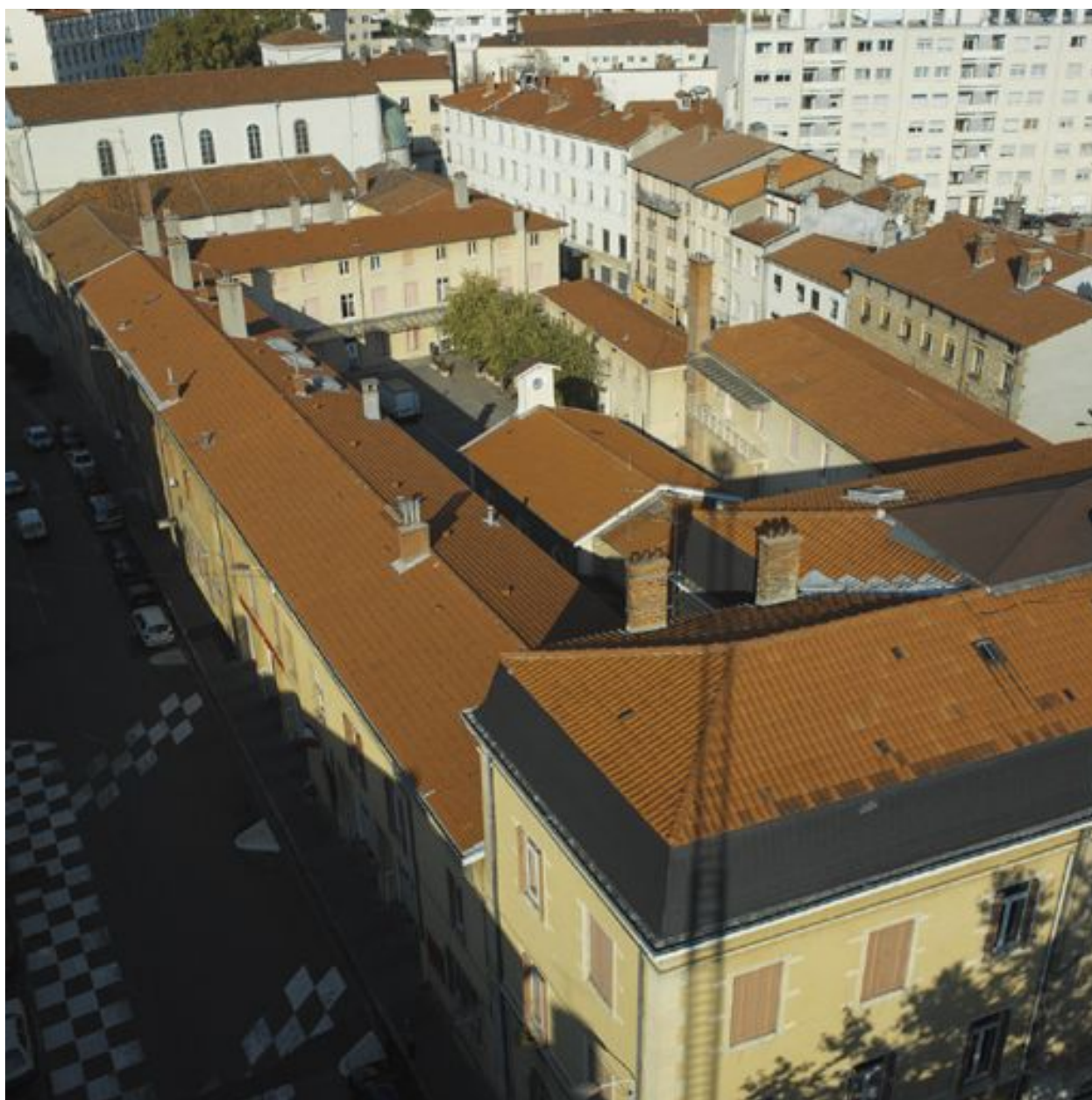
Vue d'ensemble de la caserne Rochas depuis le sud-ouest
