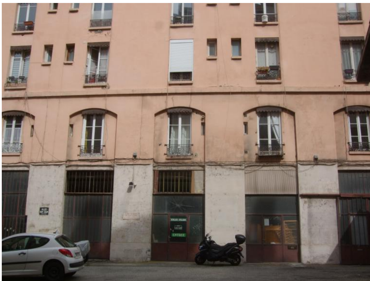
Détail façade seconde partie du bâtiment (section cadastrale 19)
