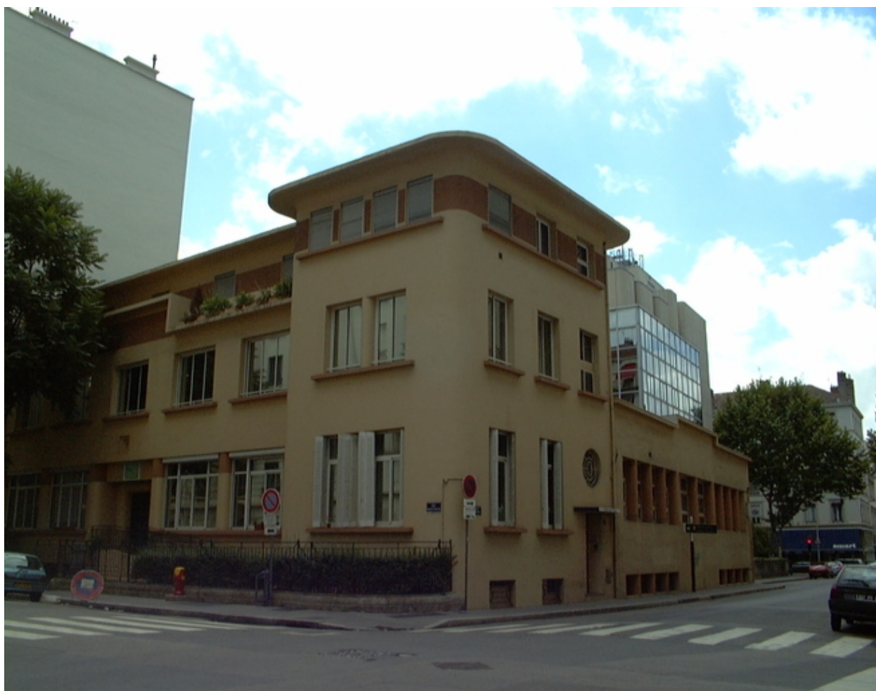
Vue nord-ouest du bâtiment
