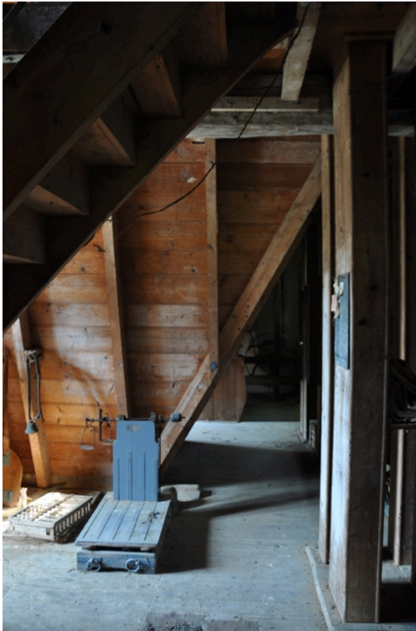
Vue intérieure du premier étage du moulin, 2009.
