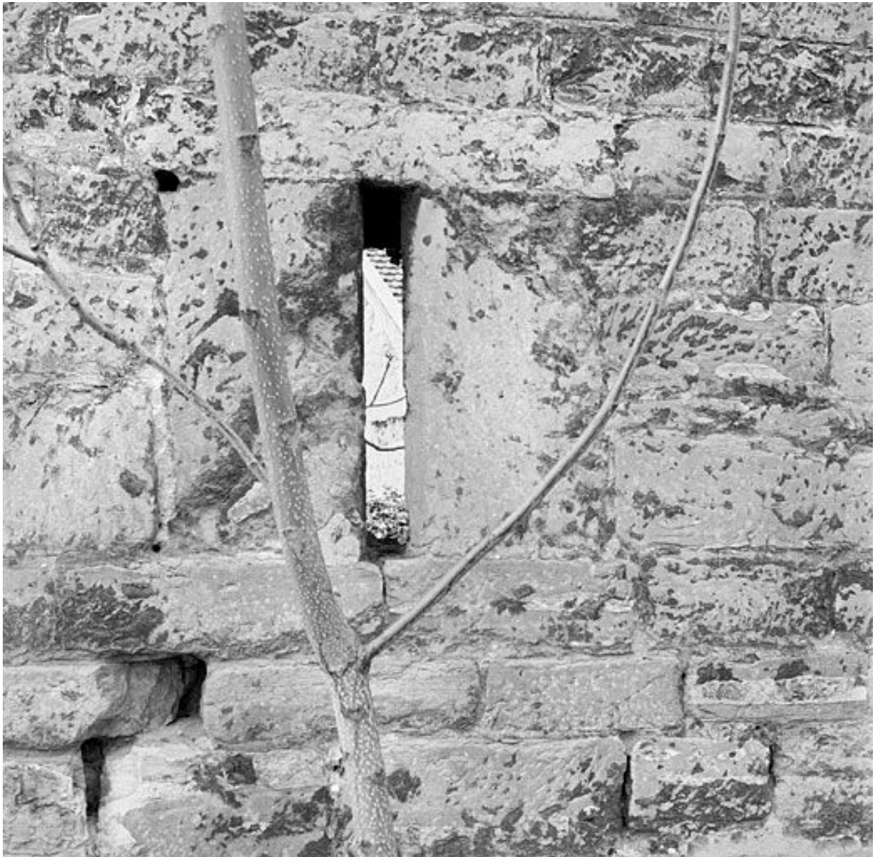
Détail d'une meutrière
