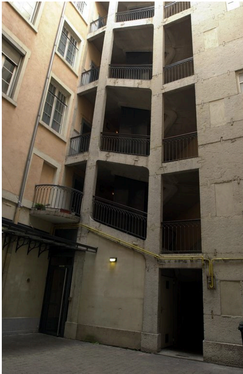
La cage d'escalier ouest
