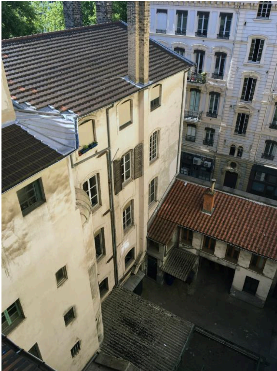
Cour annexe (ancienne cour des meuniers) vue depuis le haut
