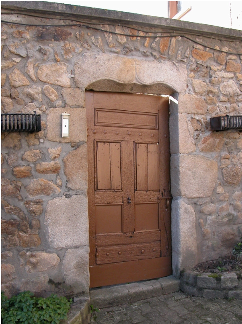
Porte avec éléments en remploi, vestige du château de Malleray (non repéré, 1986 D 60).
