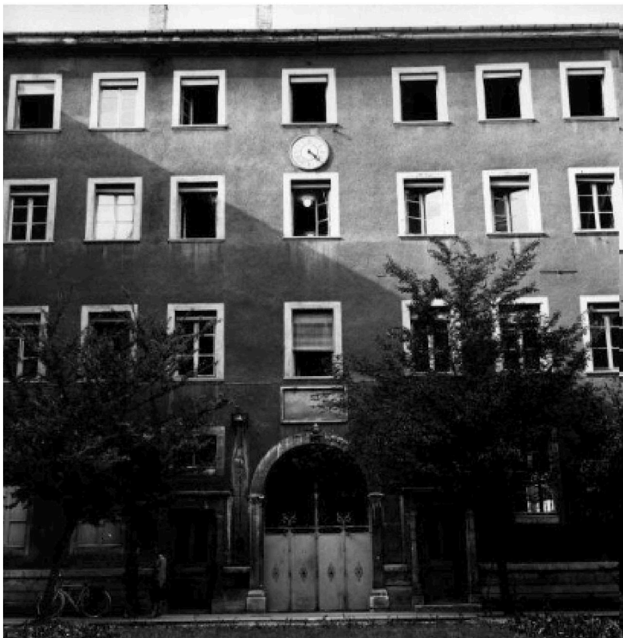
Cour d'honneur : élévation nord, en 1966 (ACM Grenoble, 3 FI 71)
