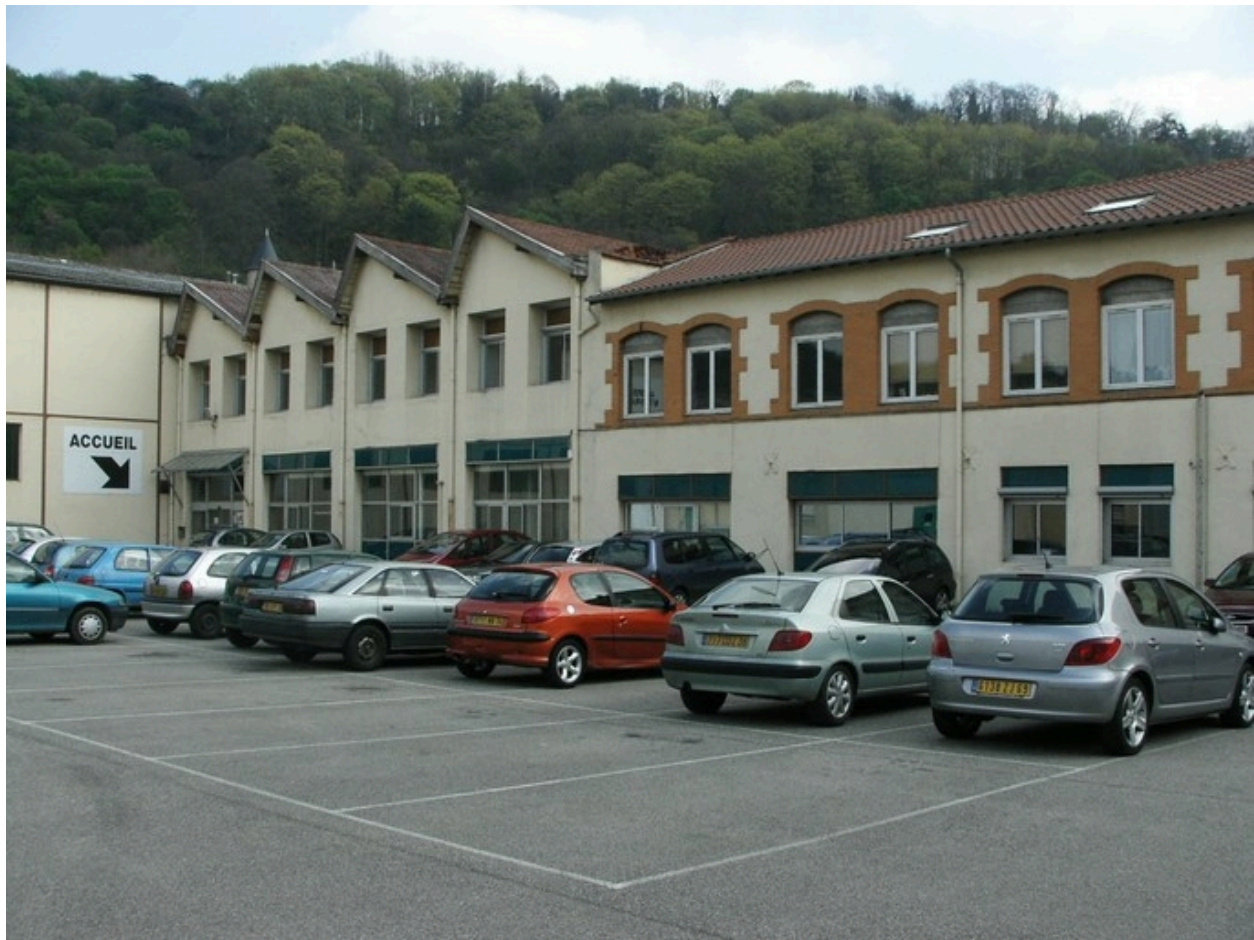
façade sud de l'intérieur de l'usine
