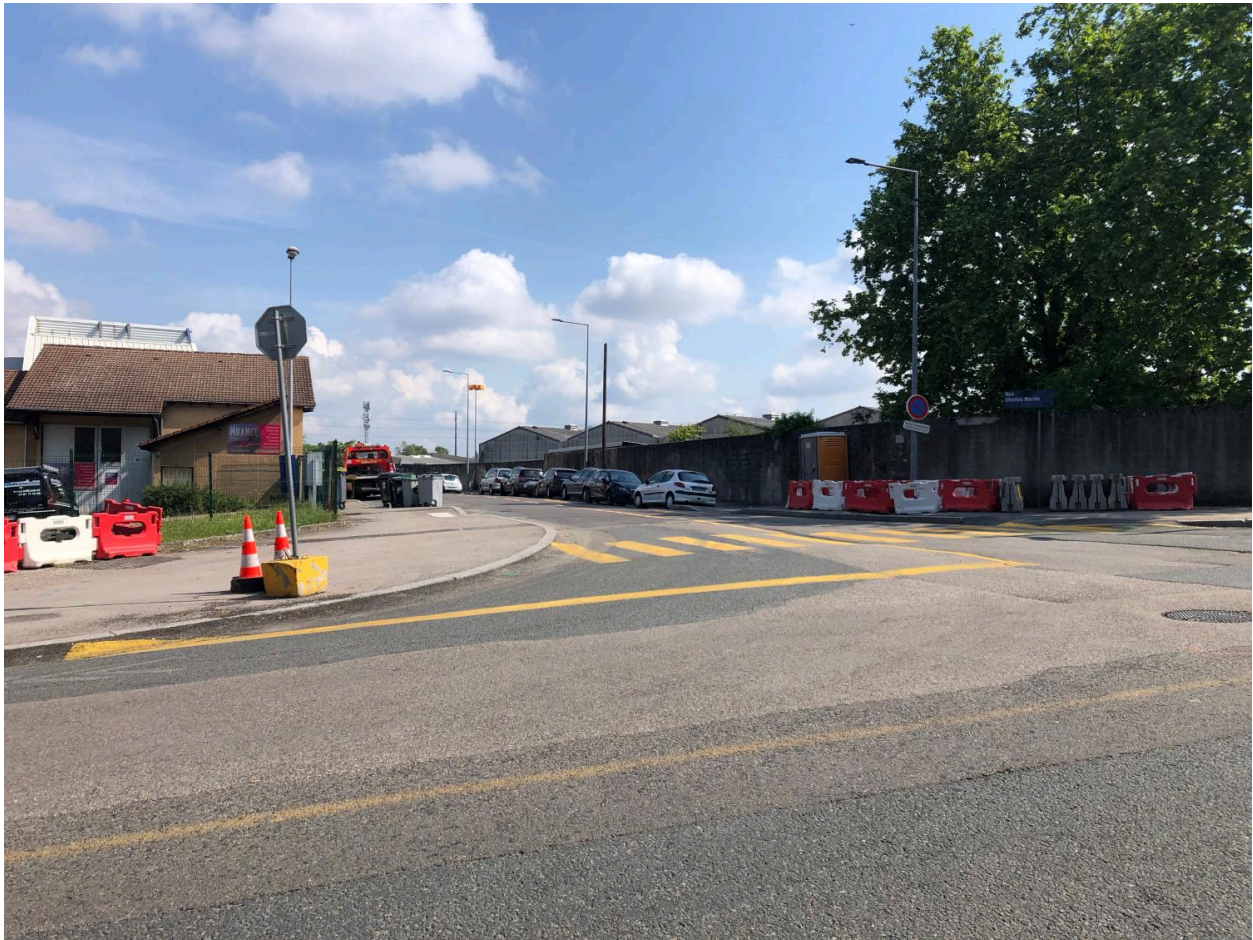
Vue nord, usine Solvay, rue Marcel Sembat
