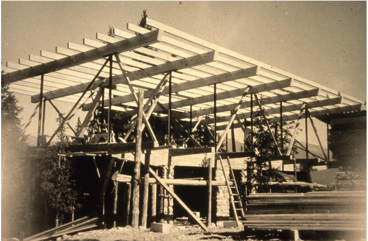
Vue du chantier de construction. Montage de la charpente. Photogr. vers 1950
