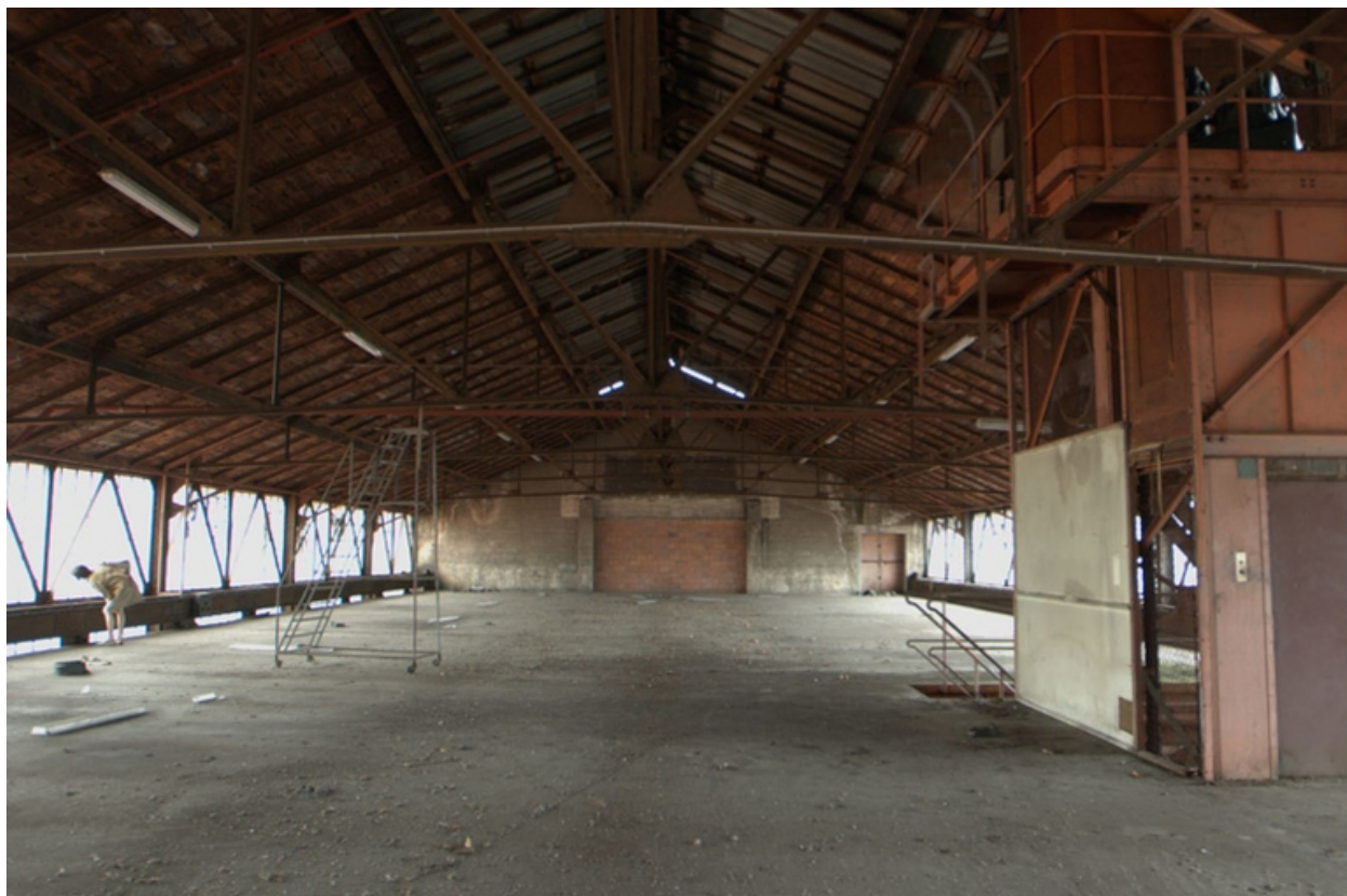
Halle centrale nord-sud, dernier niveau
