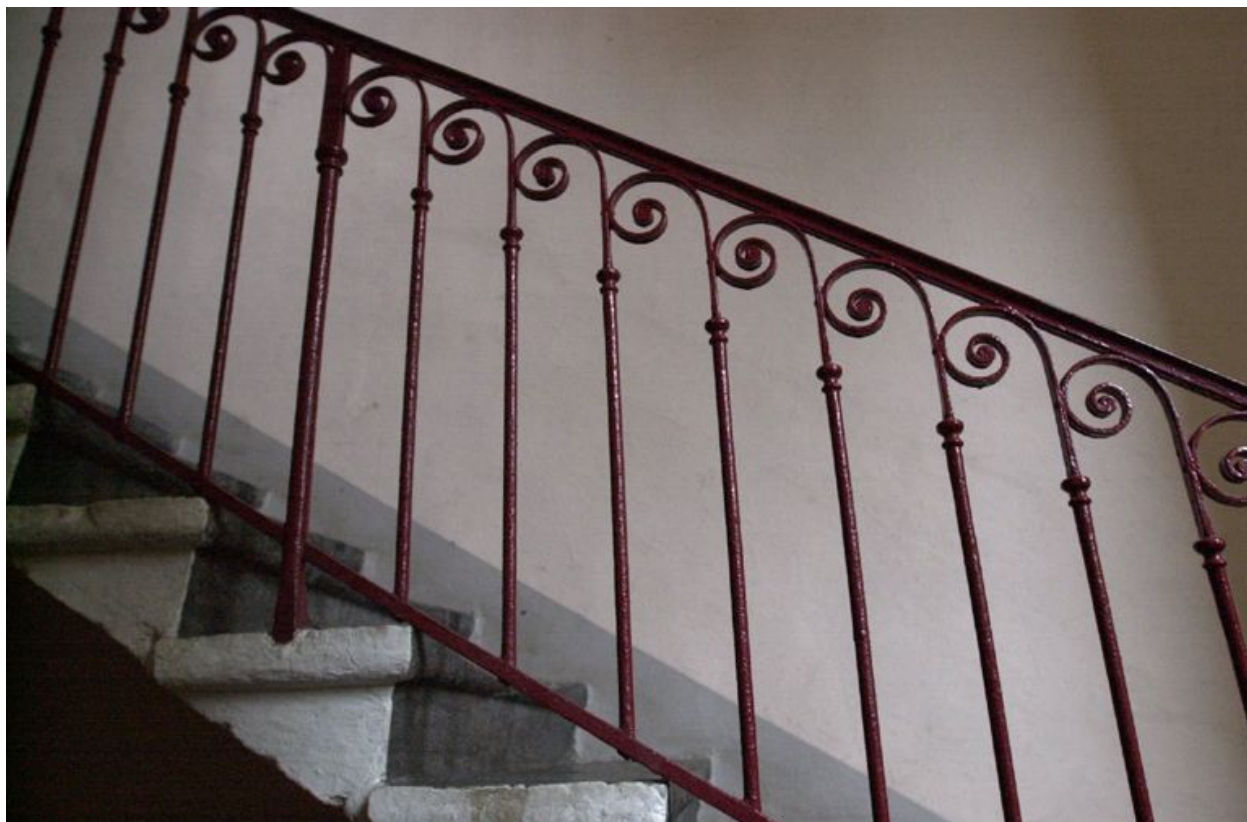
29 rue Delandine, rampe d'escalier à crossettes en fer forgé
