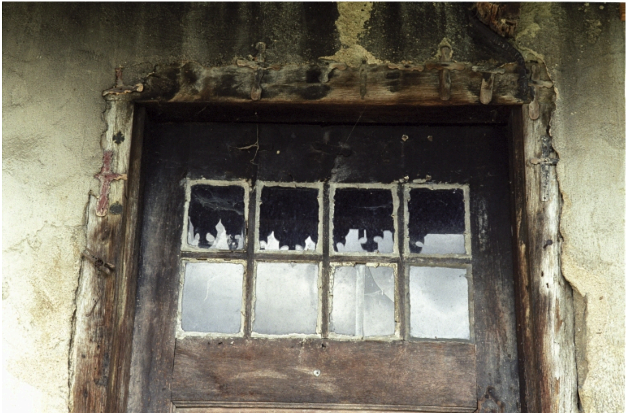
Partie supérieure de la porte d'entrée du rez-de-chaussée.
