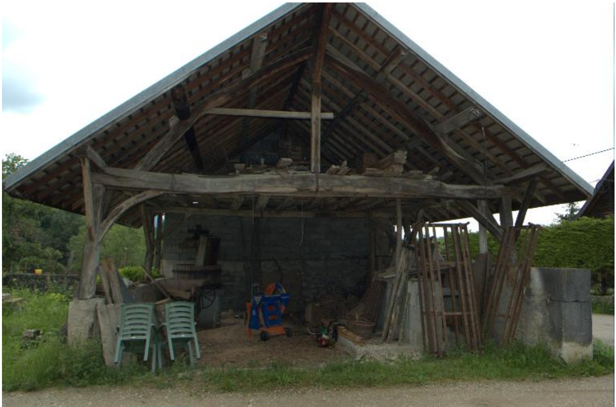
Vue d'ensemble du hangar situé en face de la ferme.
