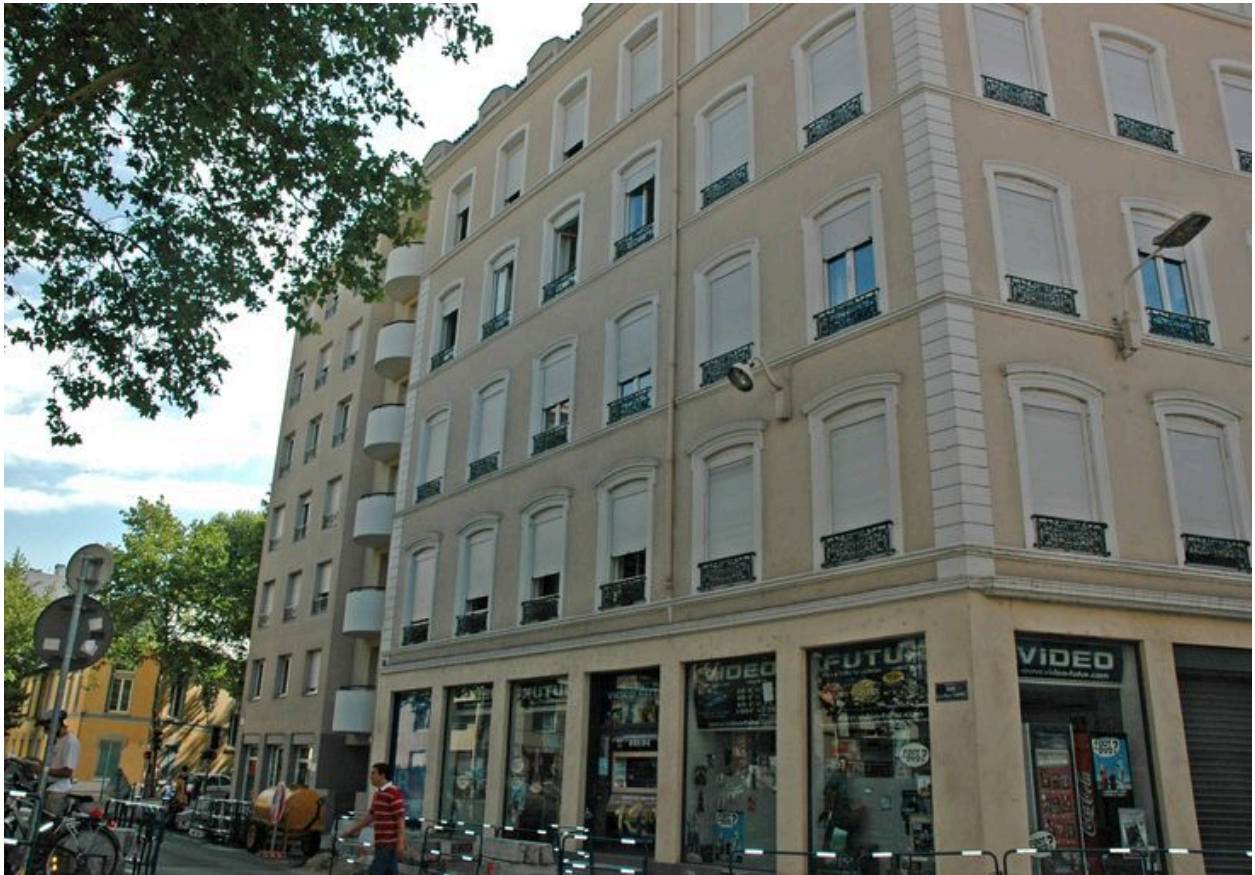
Vue de l'élévation antérieure depuis le sud-ouest
