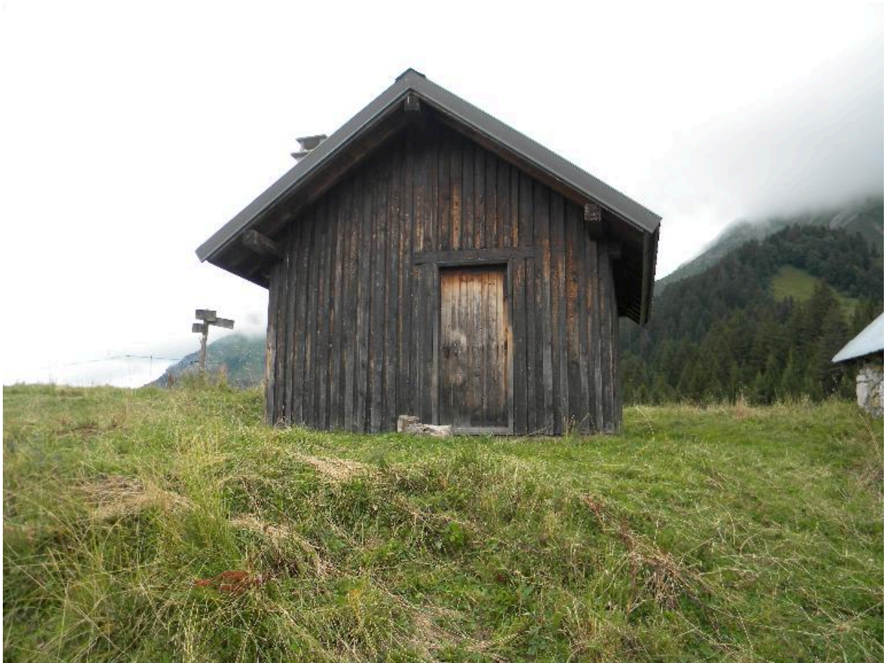
Vue d'un bâtiment en bois au sud du groupe nord.
