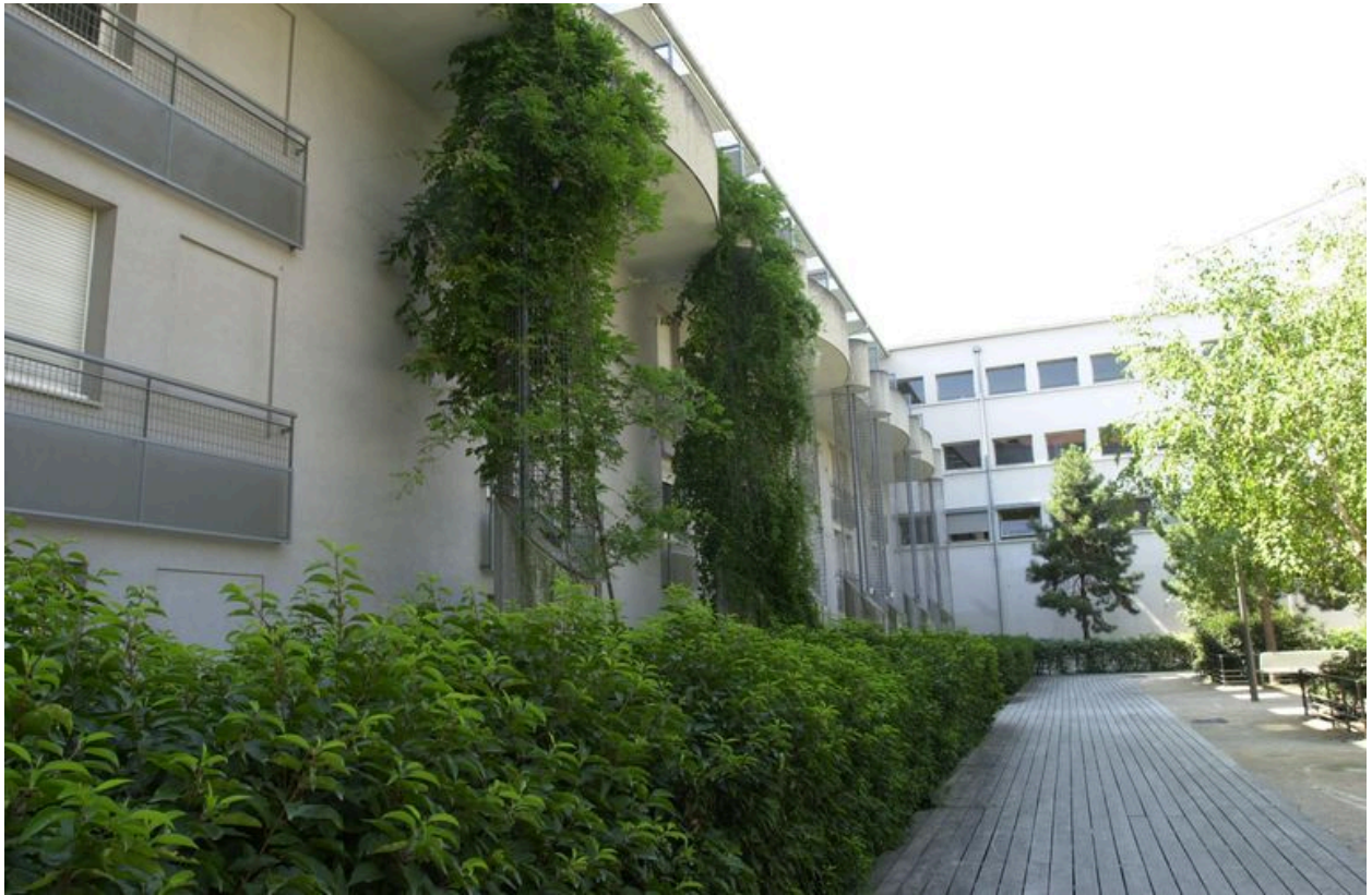
Détail des jardinières, façade postérieure du bâtiment de la rue Sébastien Gryphe
