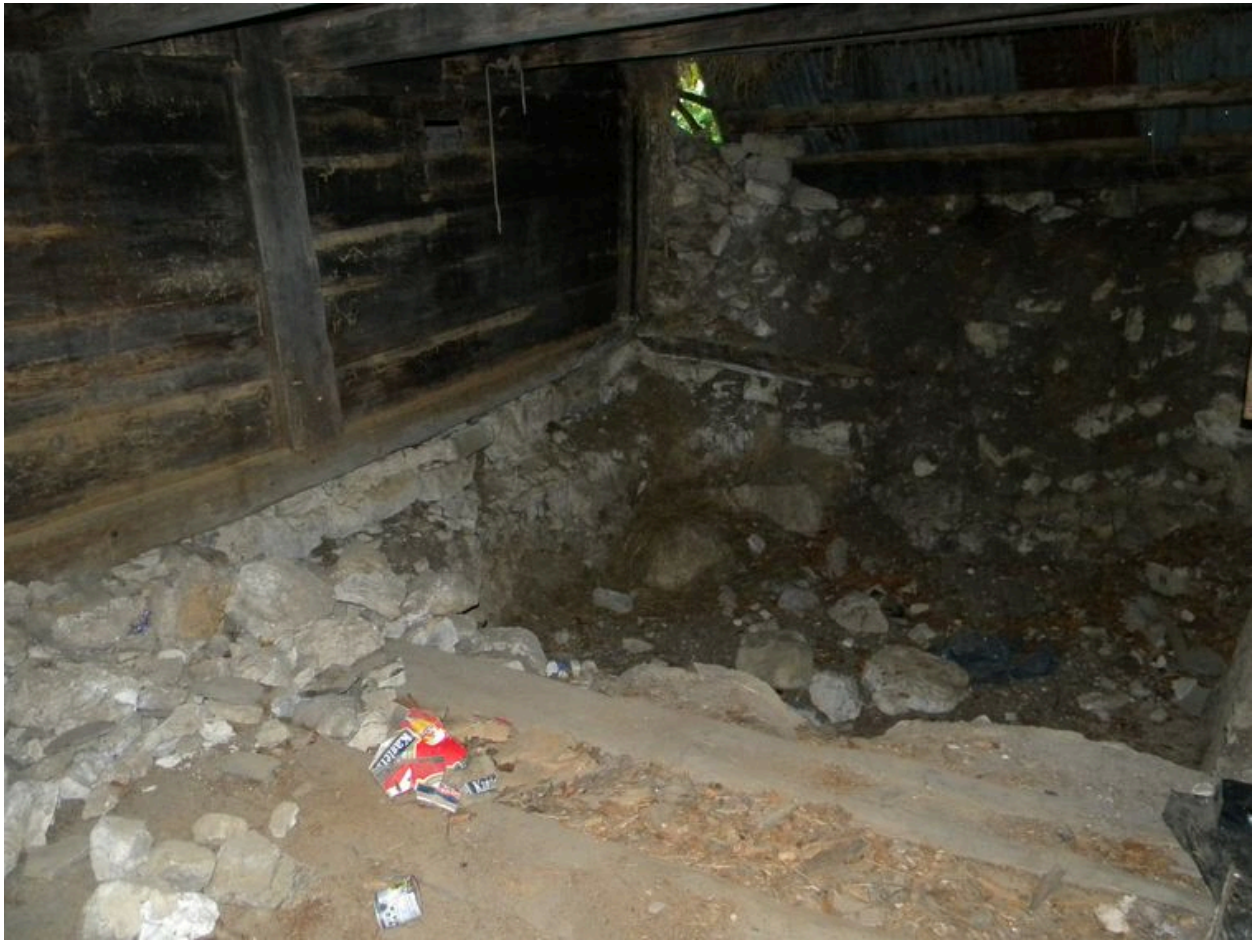
Vue d'une ancienne étable fermée par une paroi en bois.
