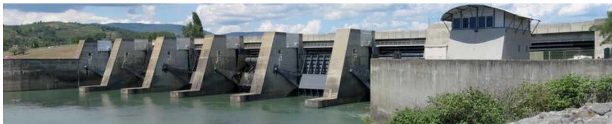
Vue panoramique, face aval (depuis la rive gauche)
