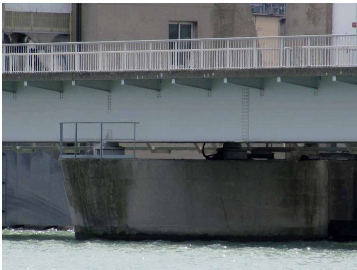
Pile du pont, face amont (depuis la rive droite)
