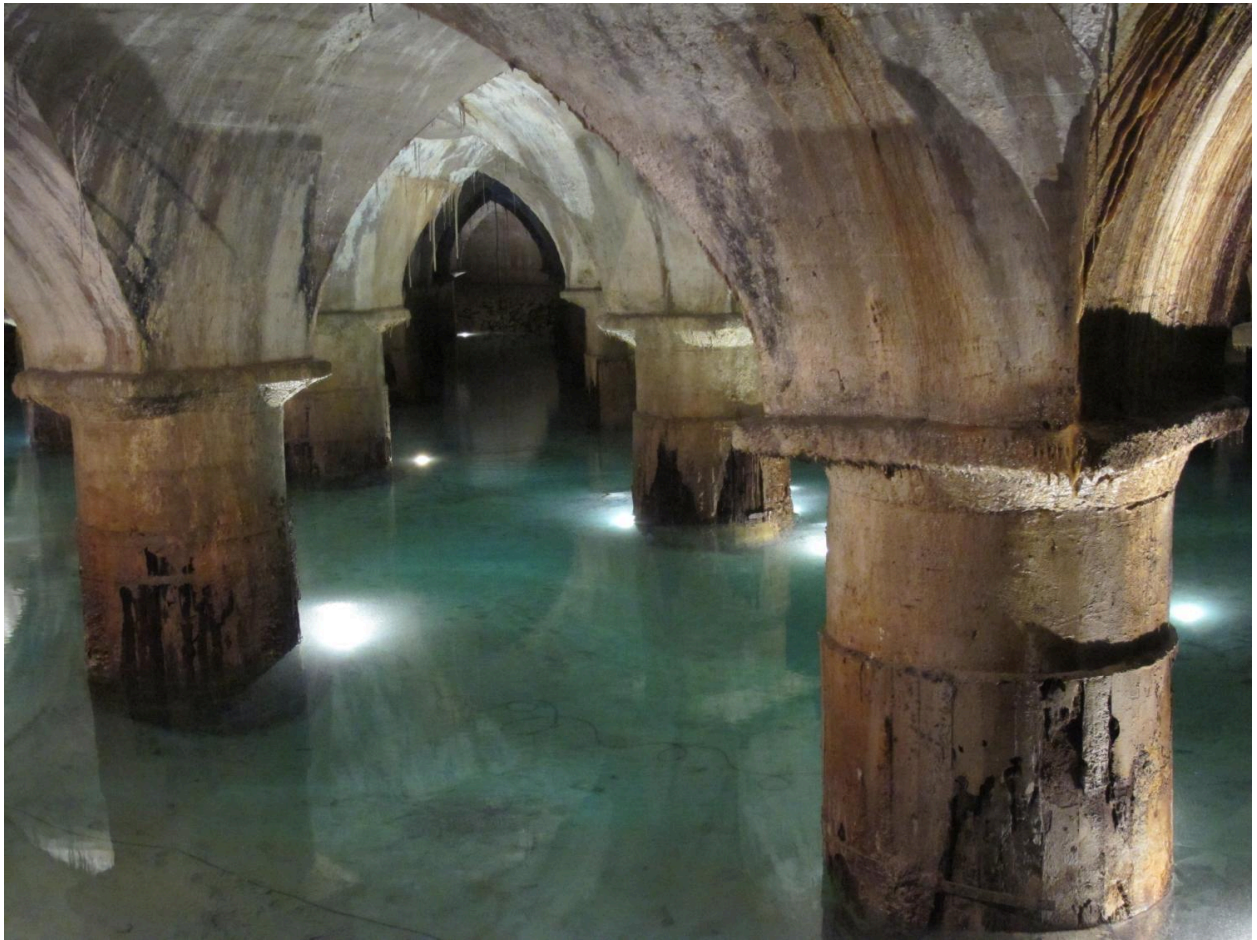
Détail bassins filtrants
