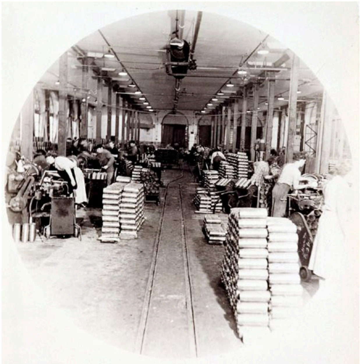
Bâtiment G, usinage du 105
