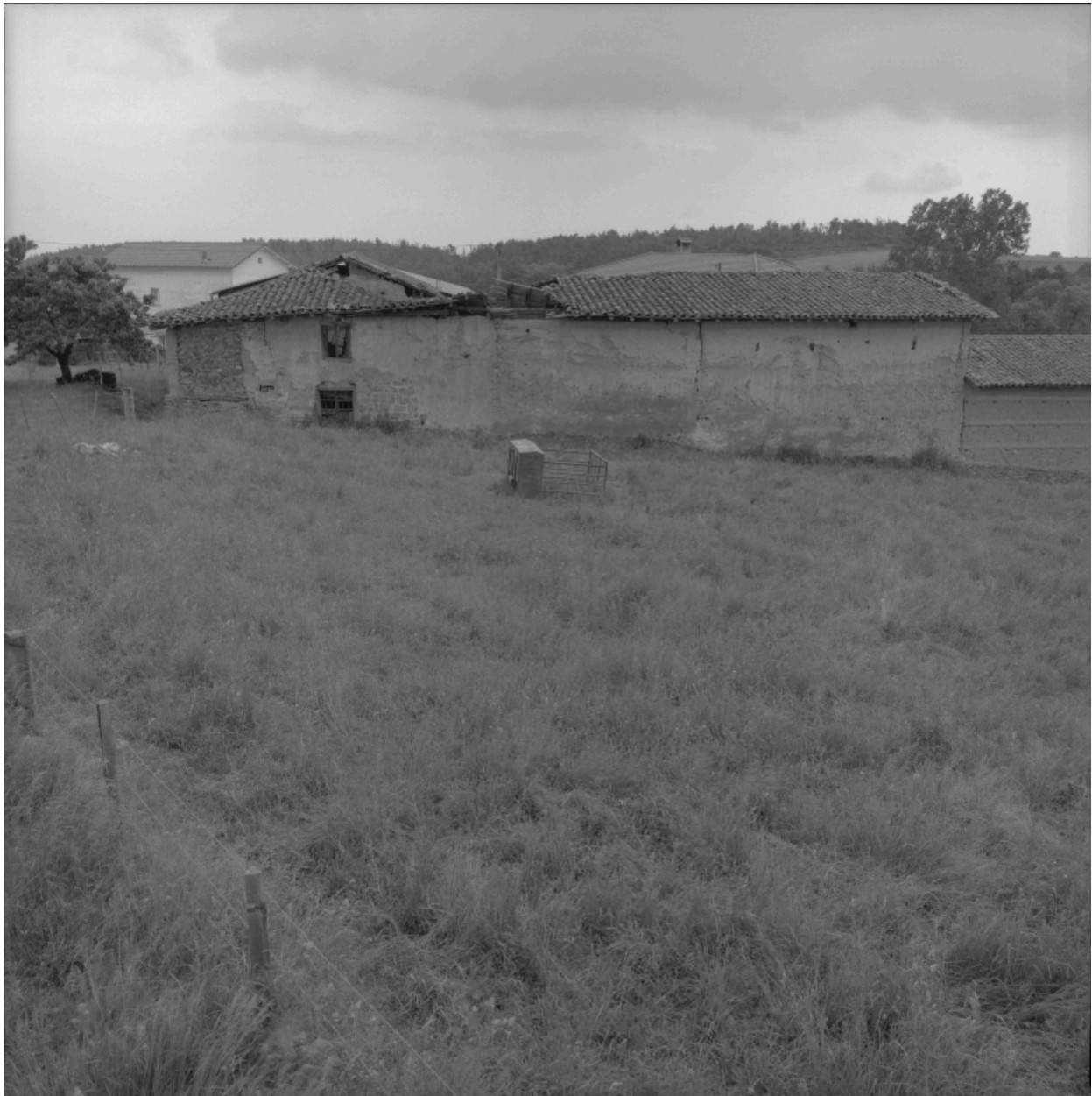
Elévations arrières de la ferme.
