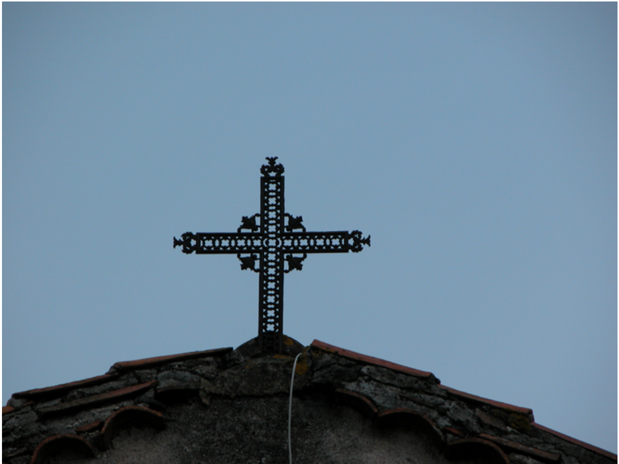
Le Bourg, roix en fonte sur le faîtage d'une maison (1988 C 33), non repérée.
