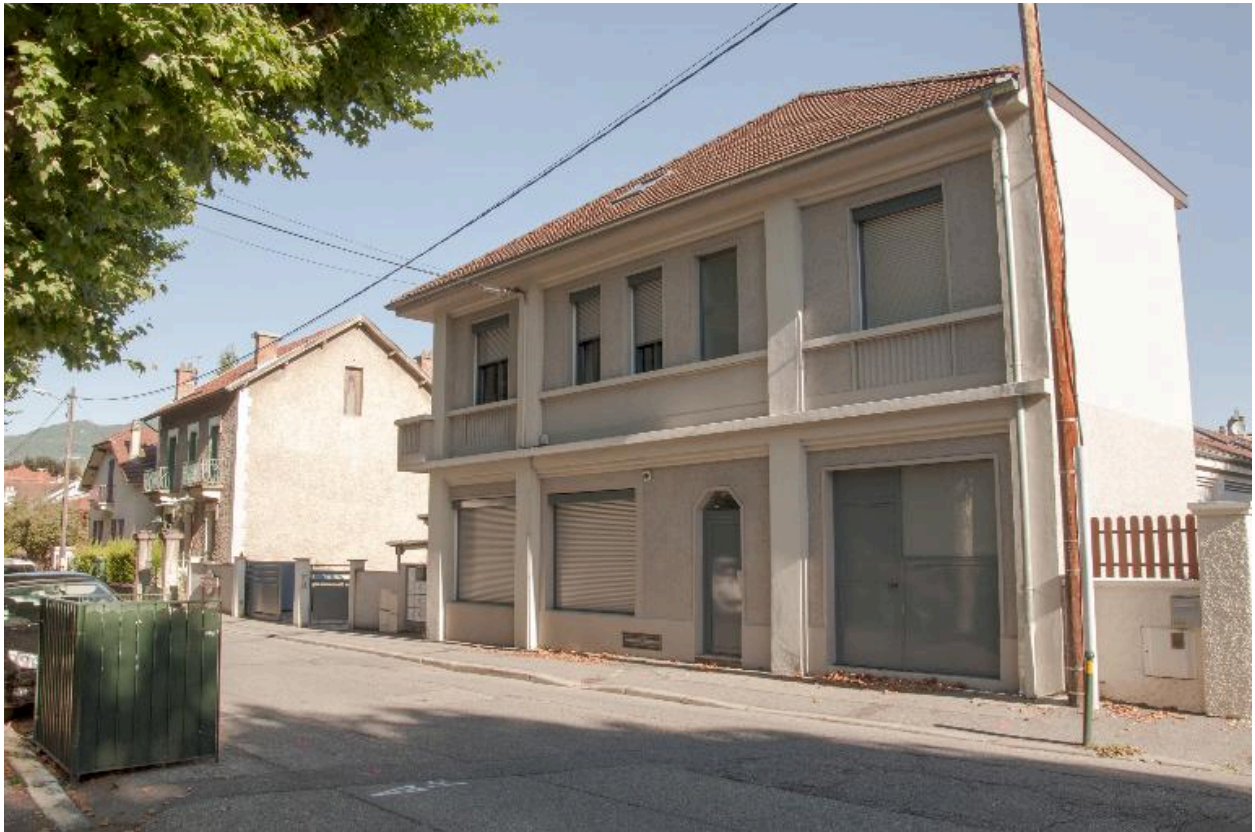
Corps de bâtiment sur rue (ancienne habitation)
