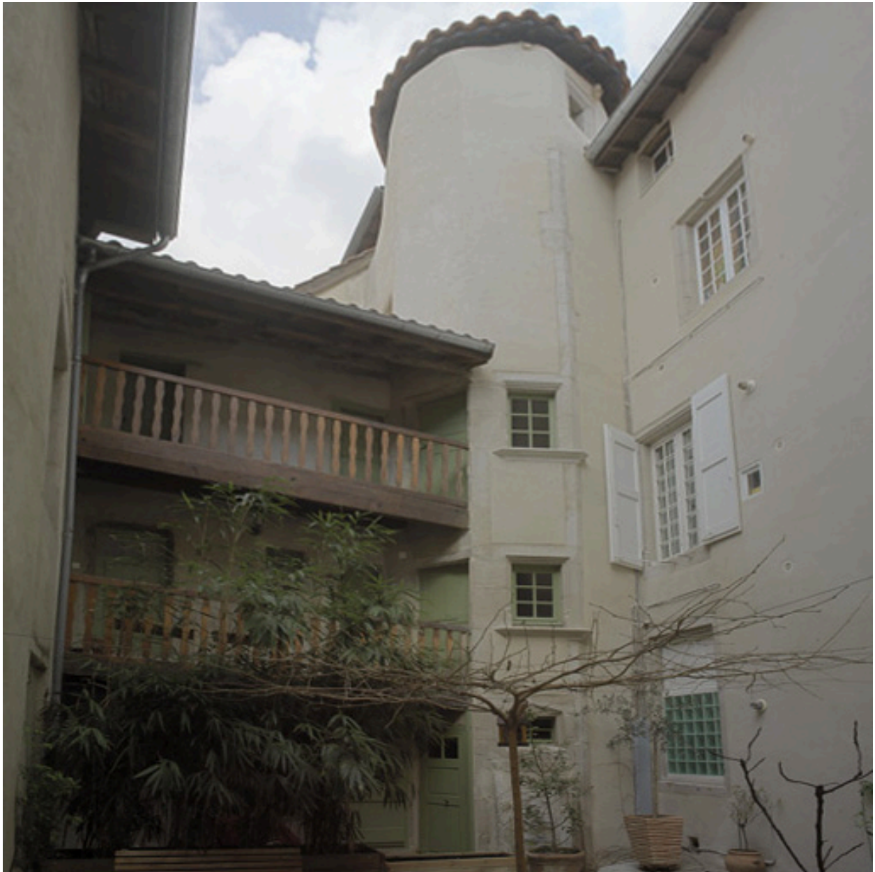
Escalier en vis demi-hors-oeuvre et galeries desservant les logis de la rue des Clercs. Vue sur cour.
