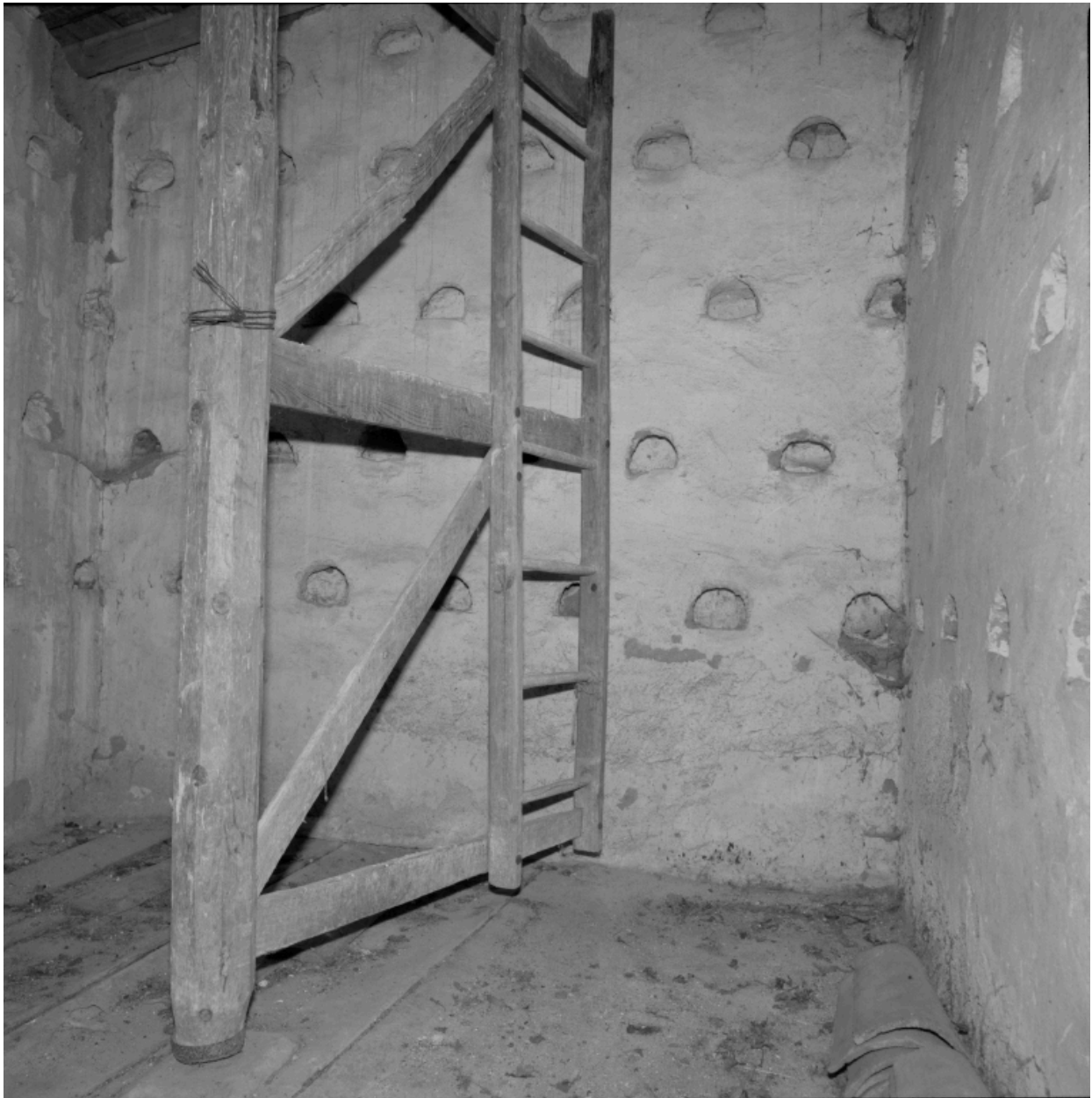
Vue d'ensemble intérieure, détail des trous de boulin.
