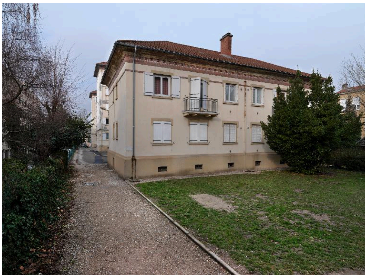
Vue d'ensemble de la rue Duviard
