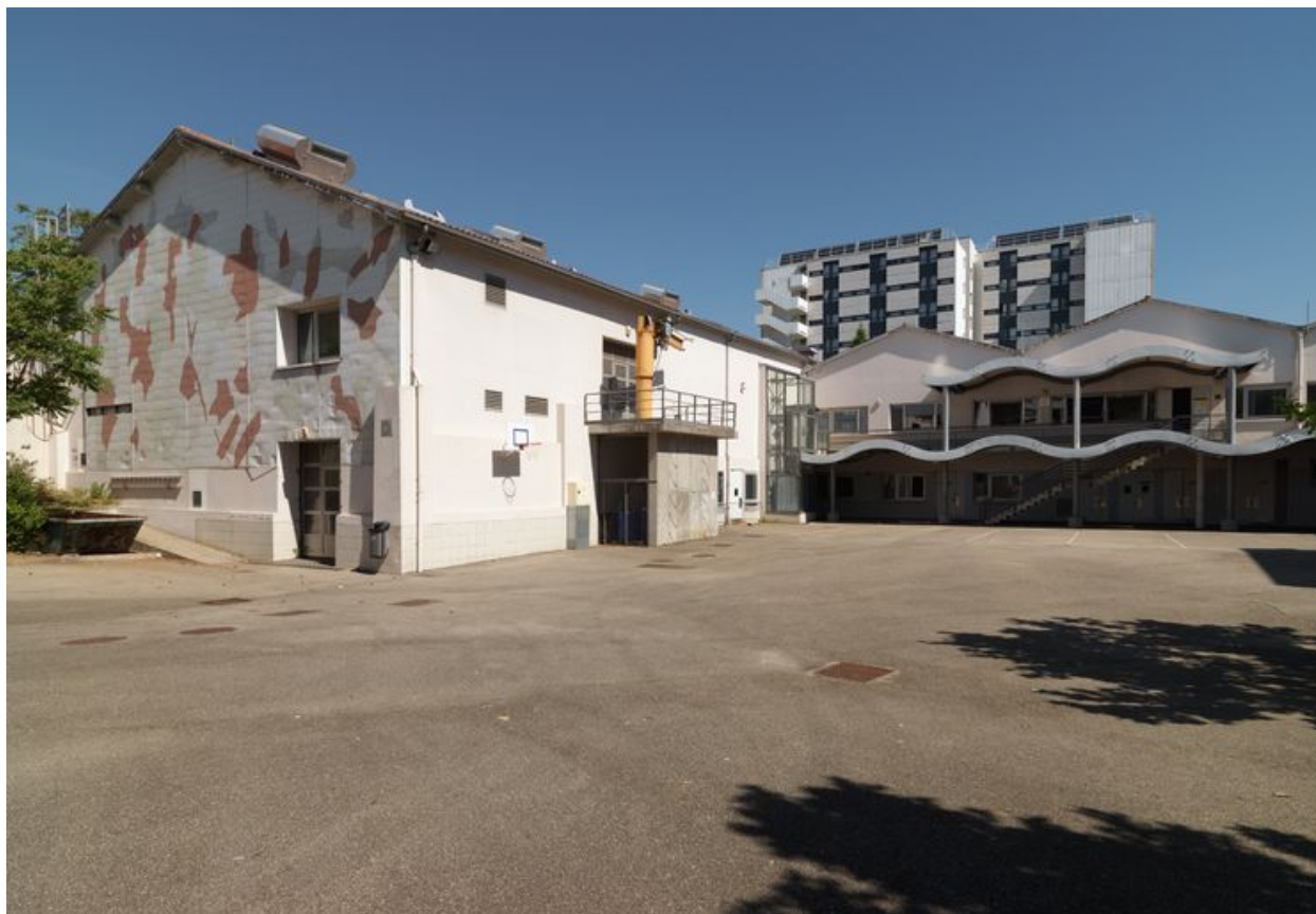
Bâtiments D et E depuis le sud
