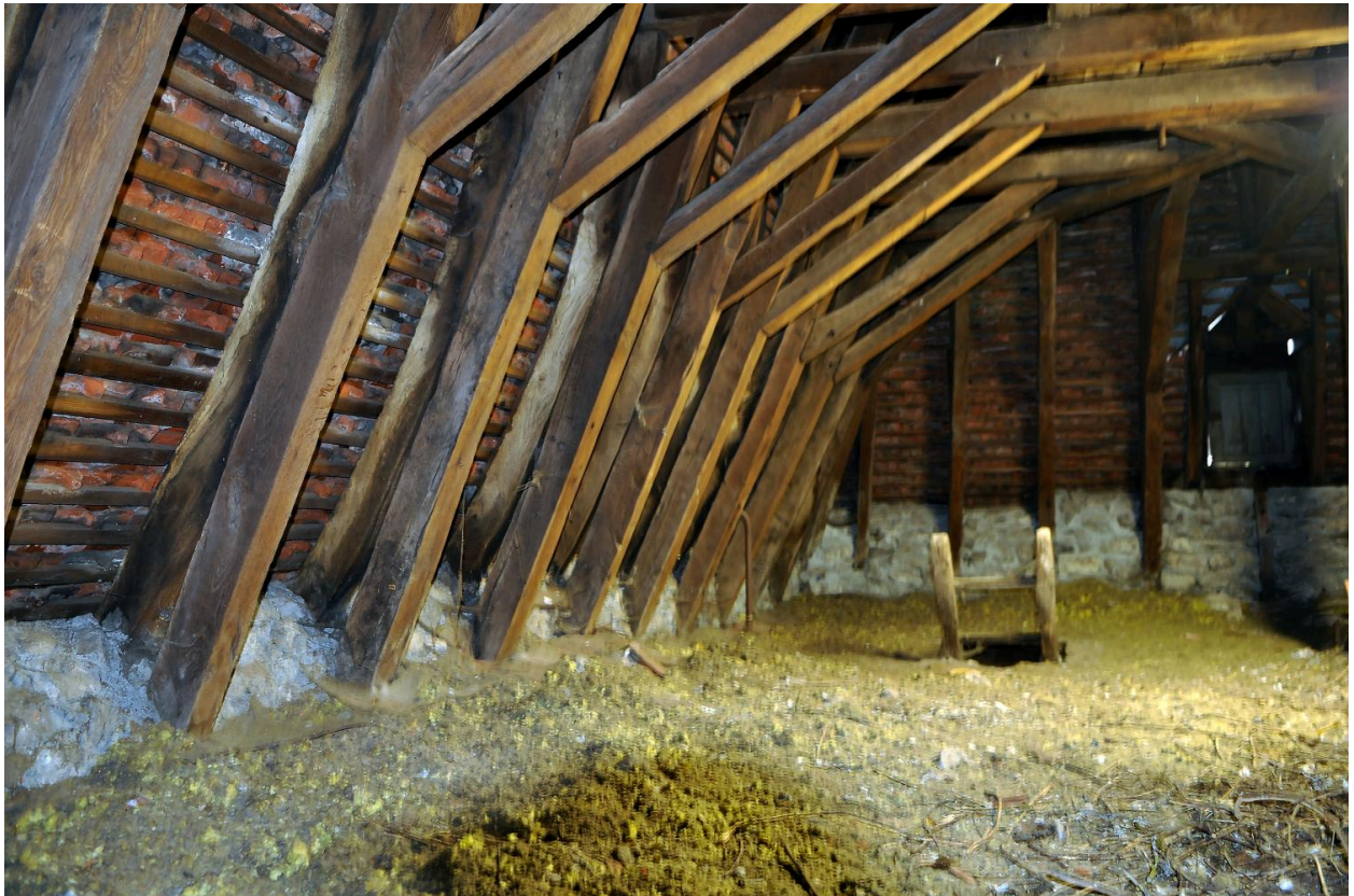
Bâtiment C : vue partielle du comble
