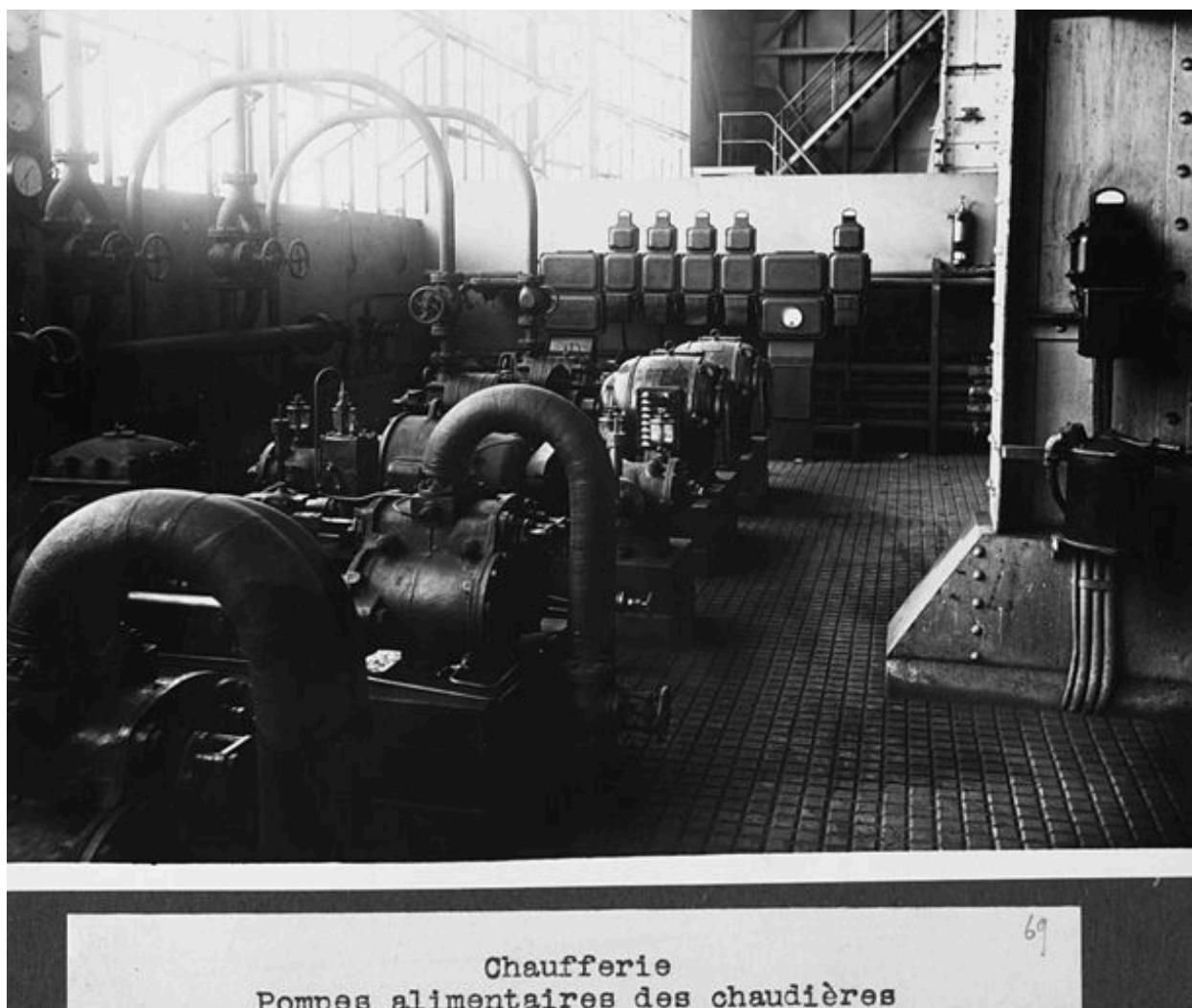
Chaufferie. Pompes alimentaires des chaudières. Photogr., vers 1960
