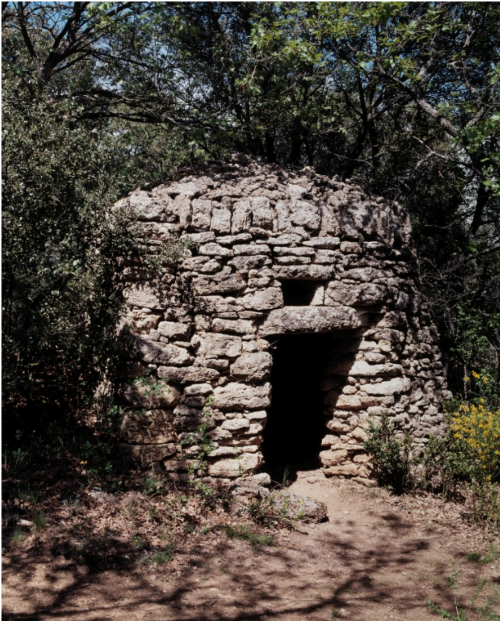
Chamaret. Les Souteras (?). Borie, vue de face.
