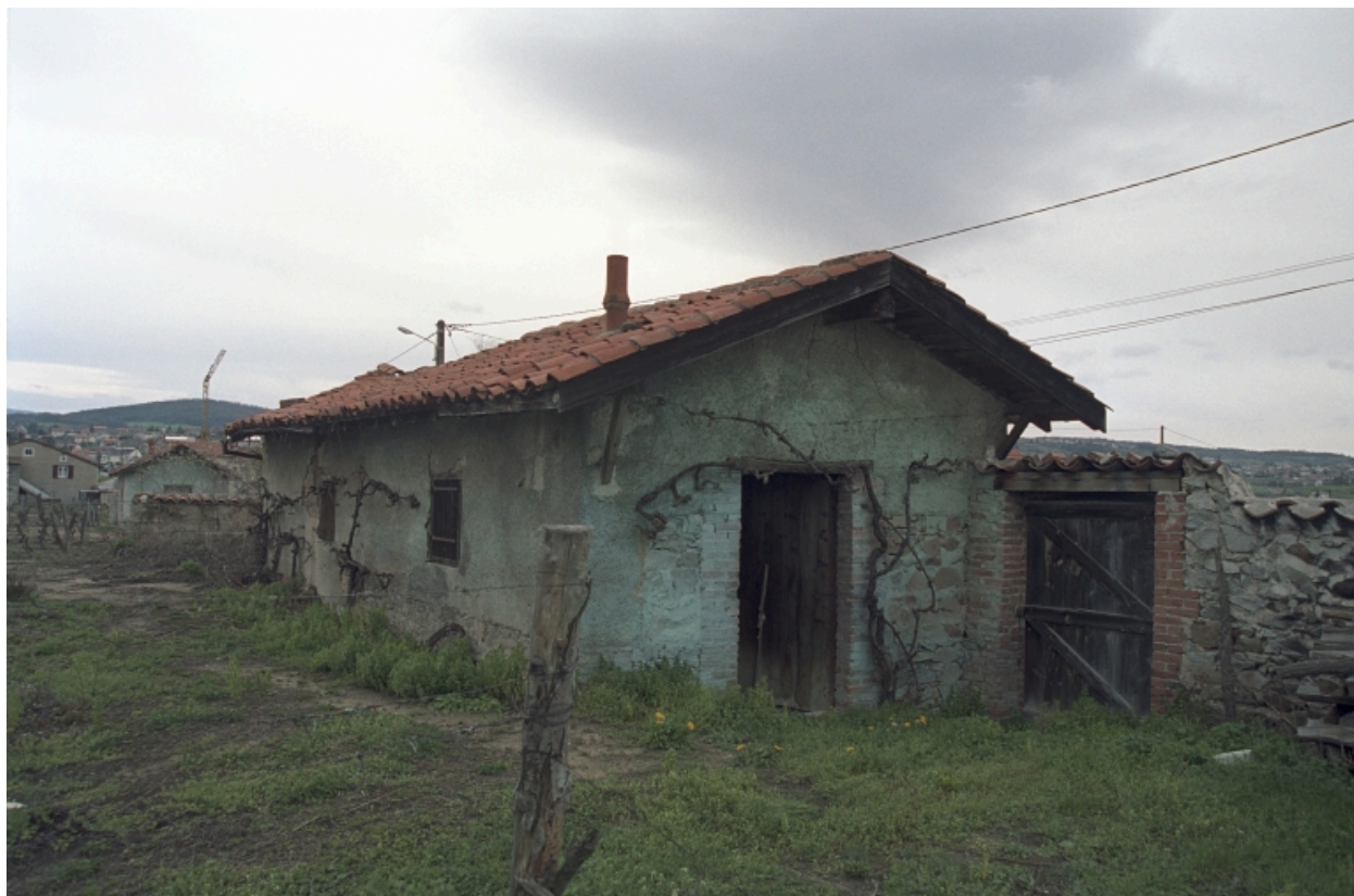
Sainte-Agathe-la-Bouteresse, Mollian (1987 C1 83,84). Loge en rez-de chaussée de type R1a1. Vue d'ensemble depuis l'intérieur du clos.
