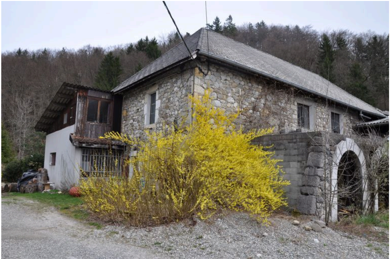
Vue du bâtiment du moulin prise depuis la cour intérieure
