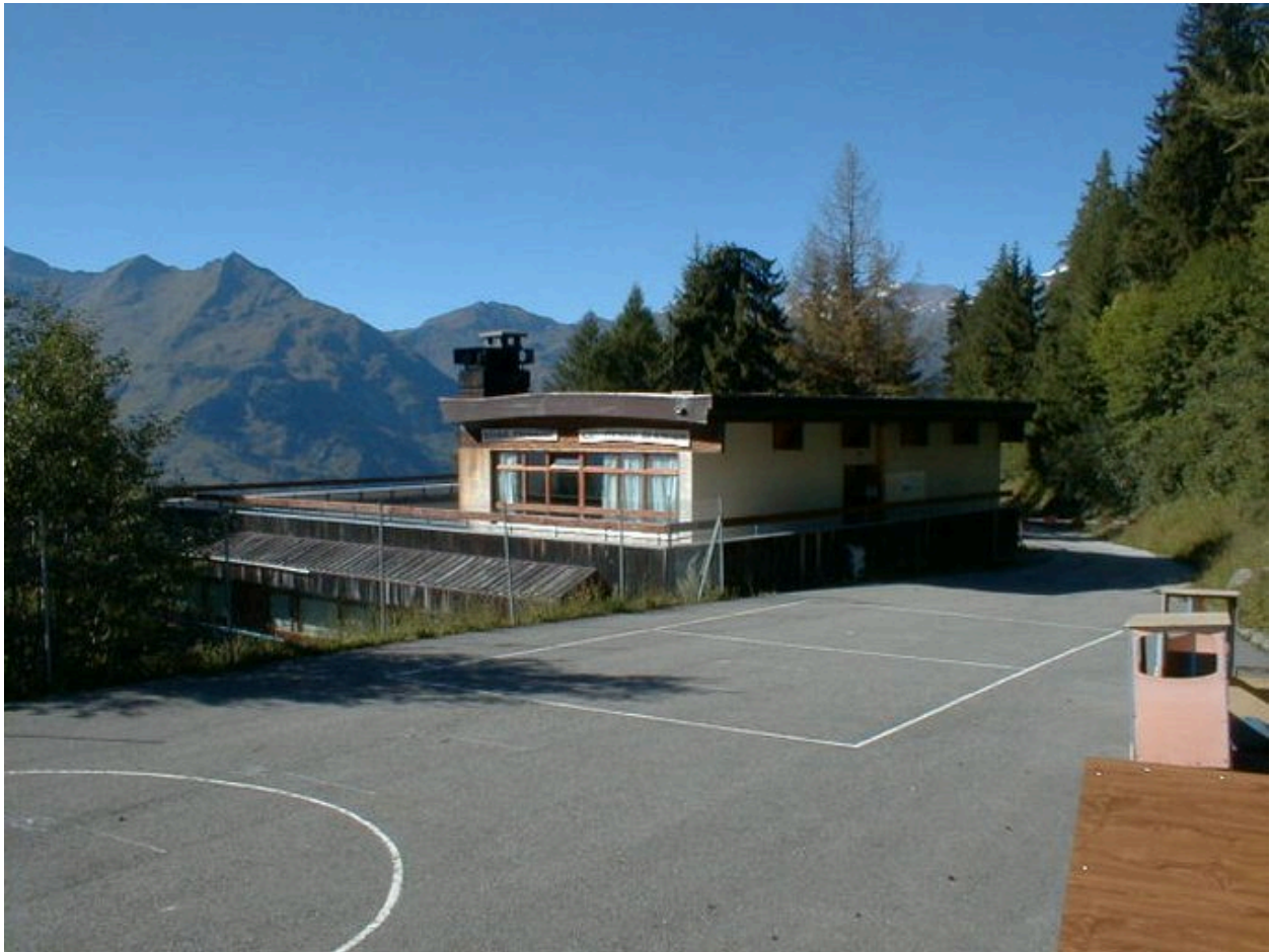
Vue depuis le sud-est
