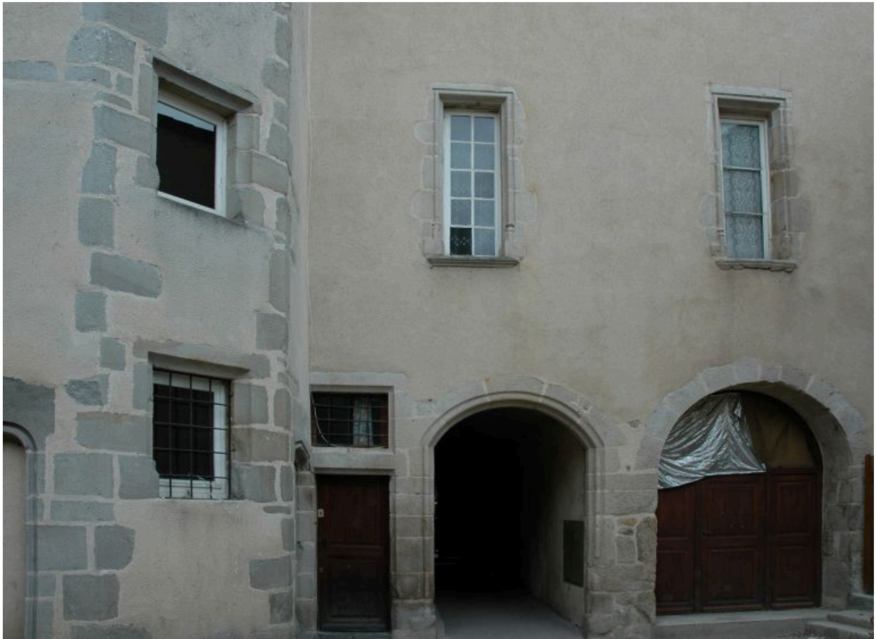
Vue du rez-de-chaussée sur cour.
