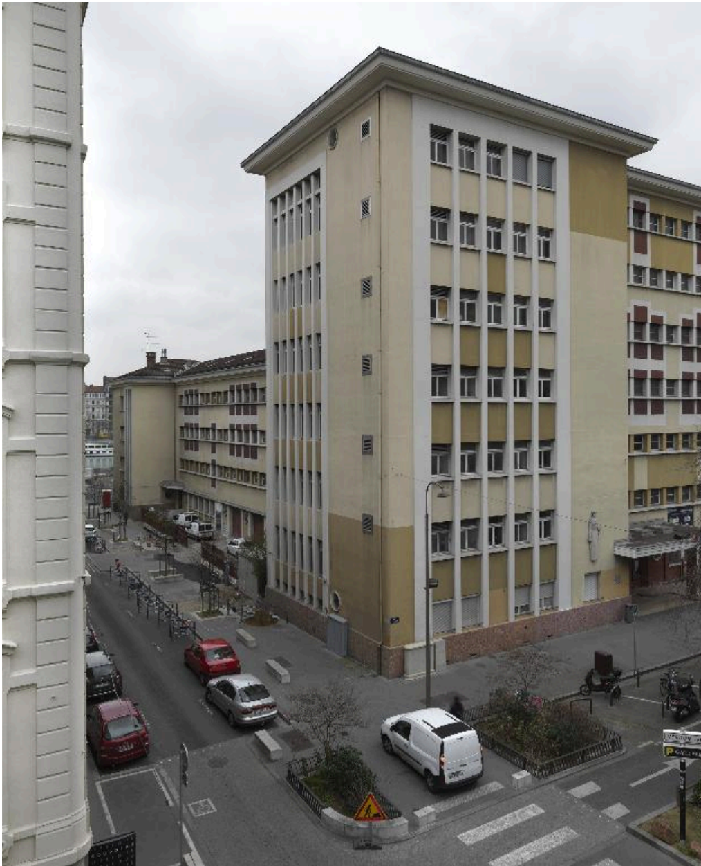
Bâtiment rue Duhamel : élévation antérieure depuis l'ouest
