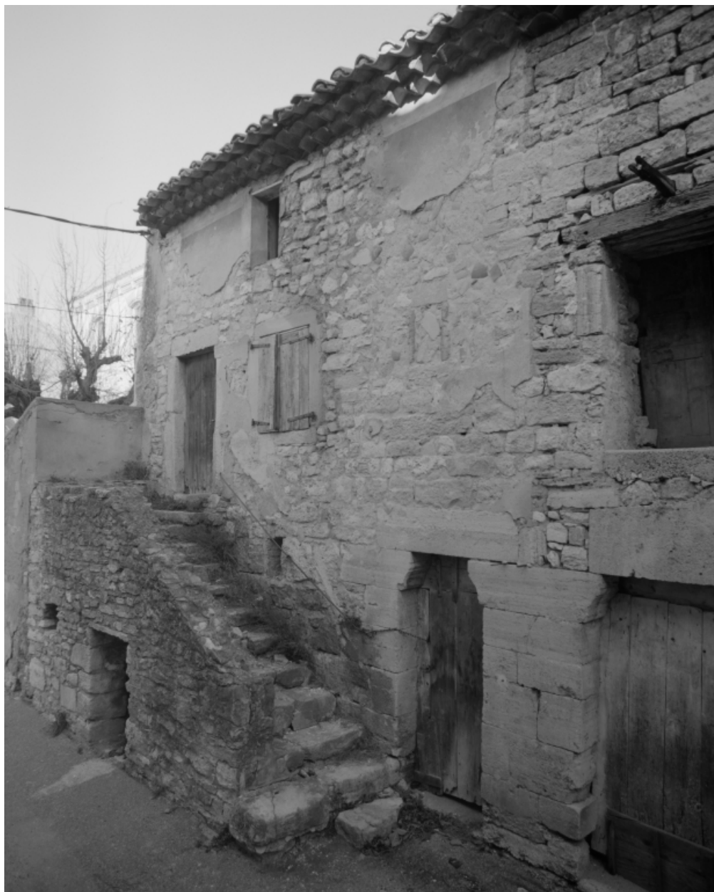
Vue partielle de la façade avant restauration (parc. A 148 et 149).
