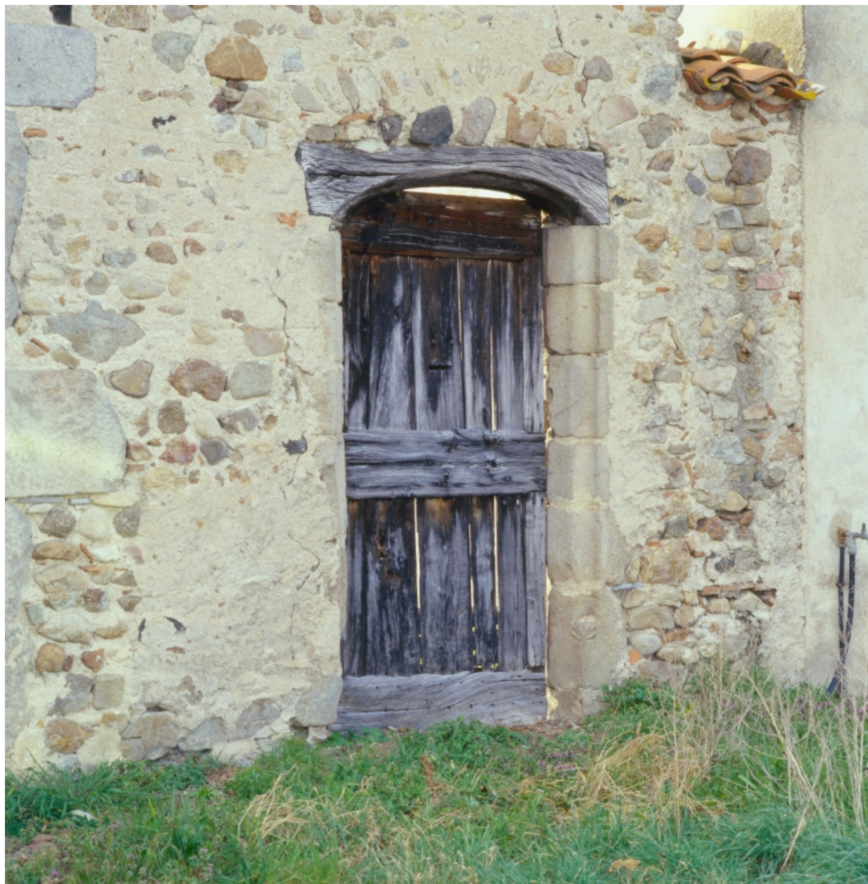
Détail de la porte piétonne d'une ferme à Meximieux, commune de Montverdun (1986 A2 400).
