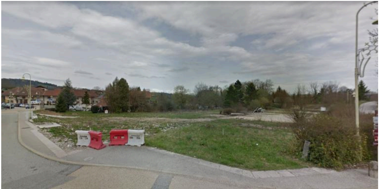
Vue d'ensemble vers l'ouest de la zone des bâtiments détruits.
