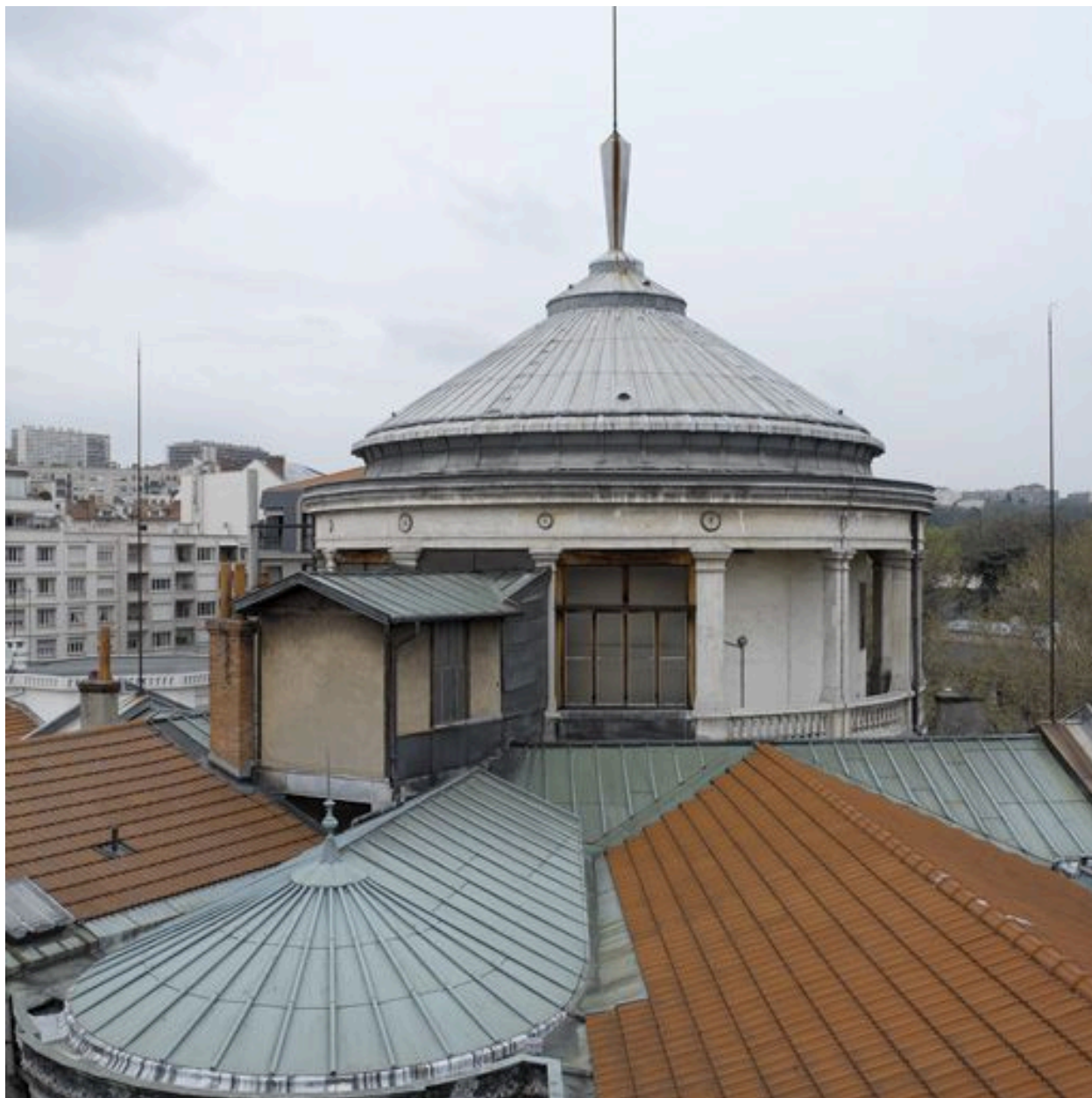
Rotonde : dernier étage et couverture depuis la toiture de l'aile Guimet
