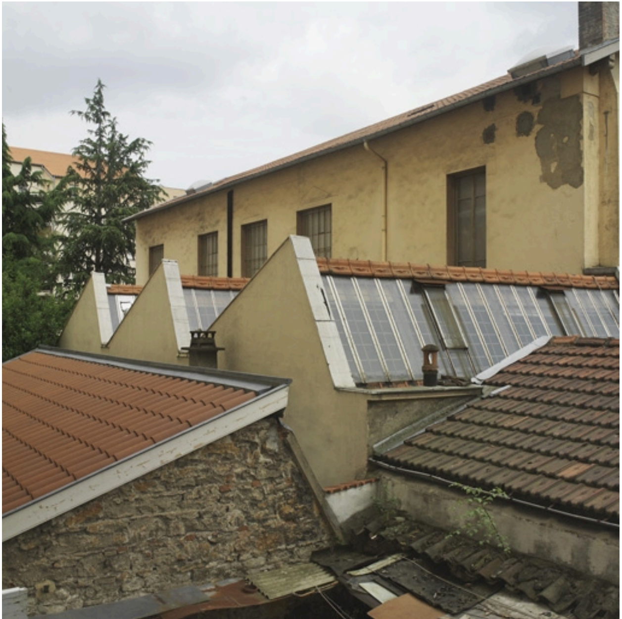
Ateliers sheds localisés à l'est du bâtiment central
