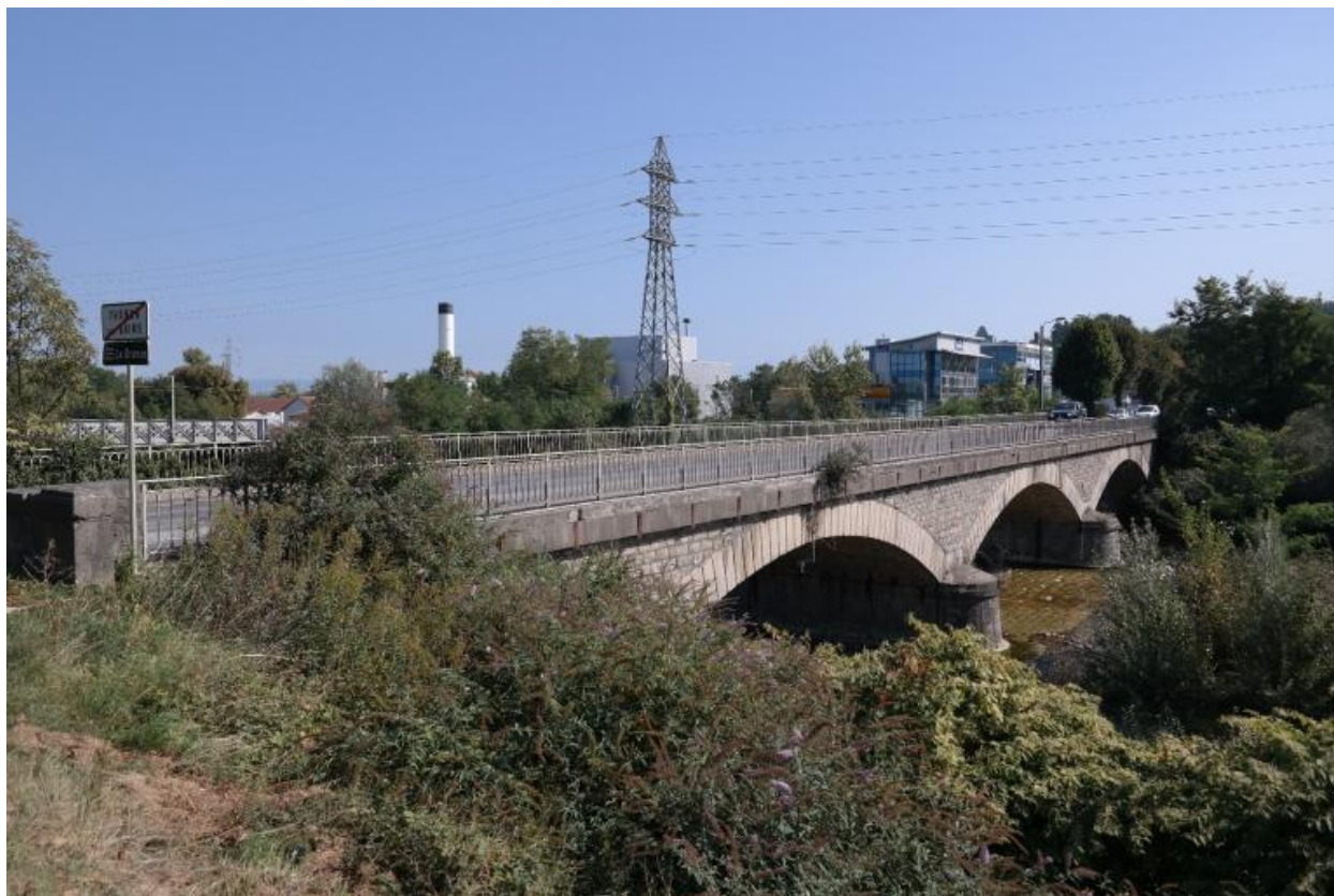
Vue générale du pont de Dranse
