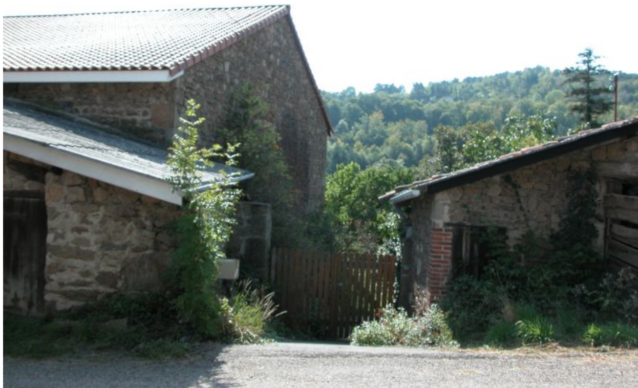
Vue d'ensemble de l'accès nord à la cour de la ferme.
