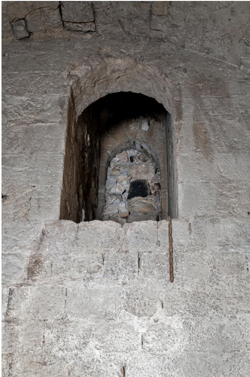
Donjon, 3e niveau : baie ouvrant sur escalier en vis médiéval
