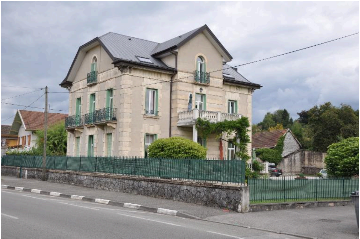
Vue d'ensemble depuis la rue
