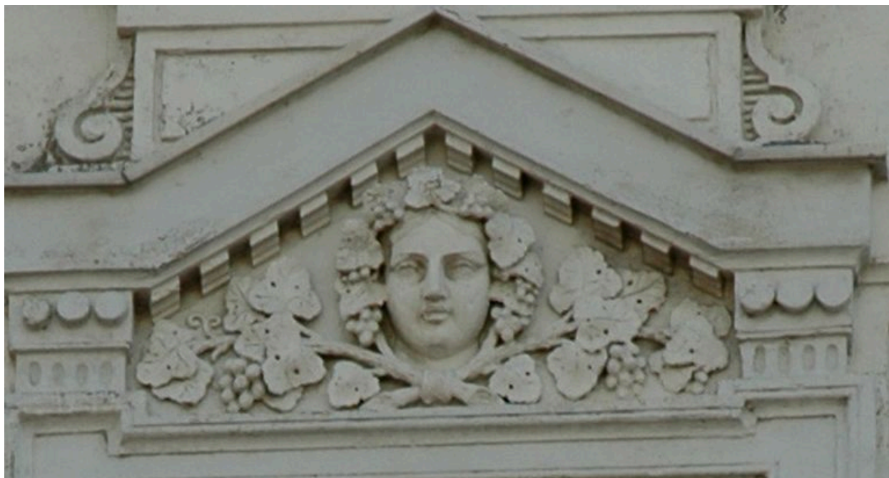
Détail du fronton de la fenêtre de la 4e travée, 3e étage
